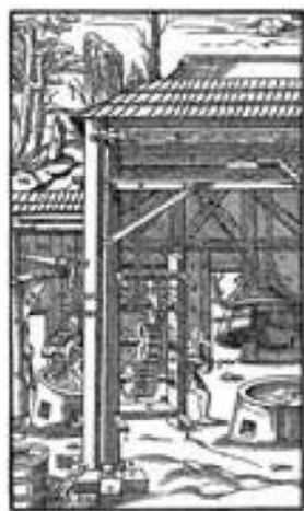
画像③ 炉蓋吊り用手動クレーン
