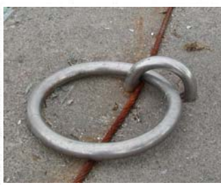
③知床半島の付け根、ウトロ漁港の係船環（弊社製造設置後7年、サビ発生なし（03年5月撮影））
