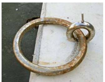
②鳥羽漁港のサビた磁石につく係船環（取付部に磁石がひっついている）
