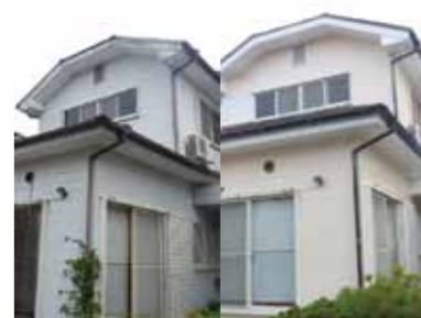
施工前 施工後
