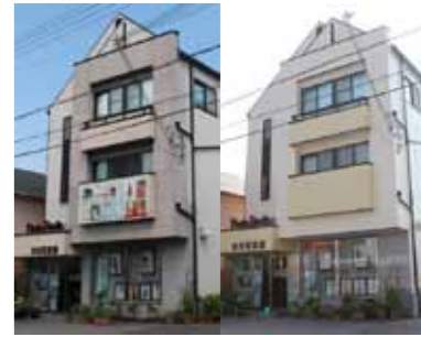
施工前 施工後
